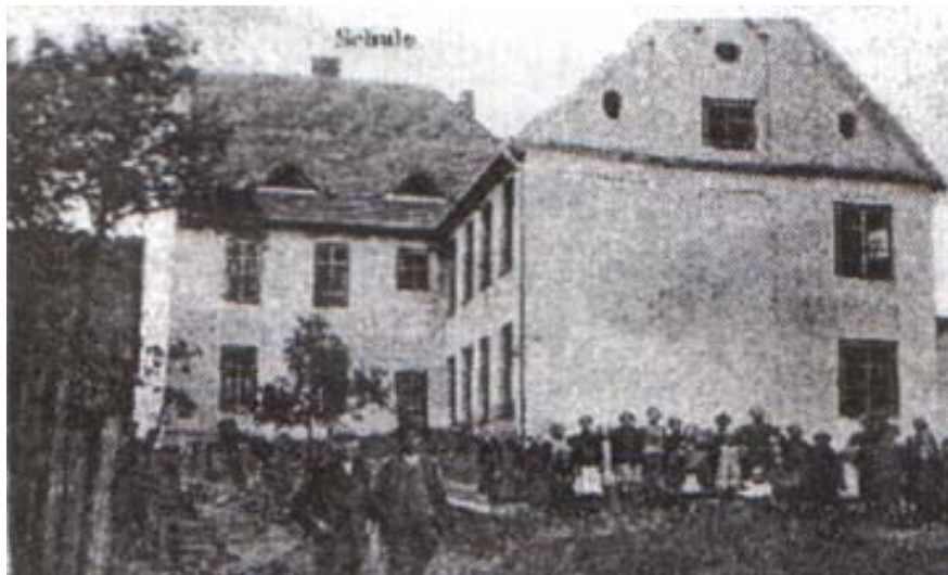
Budynek szkoły wybudowany w 1910 r. Do 1988 roku mieściła się tu szkoła podstawowa
